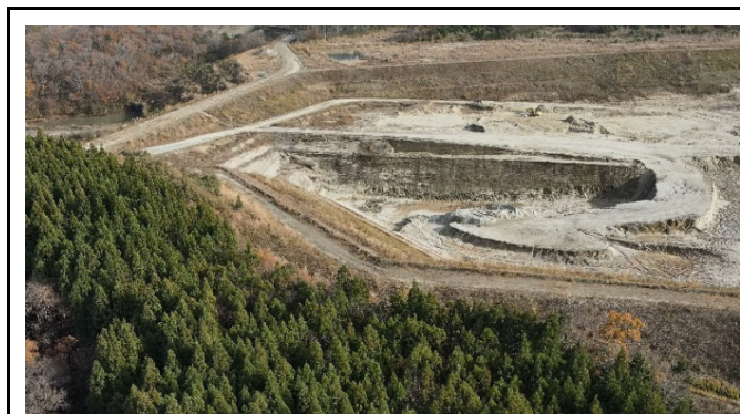
造成工事箇所
