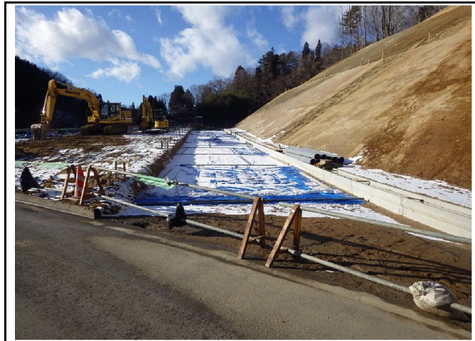
基礎地盤掘削作業の状況
