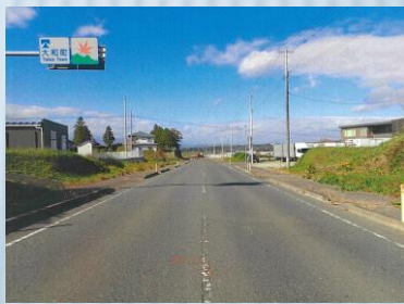
県道大和松島線の路面改修 (大平下地区)
