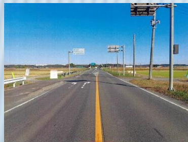
県道塩釜吉岡線の路面改修 (大崎地区)
