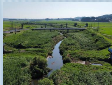
西川の河道掘削
