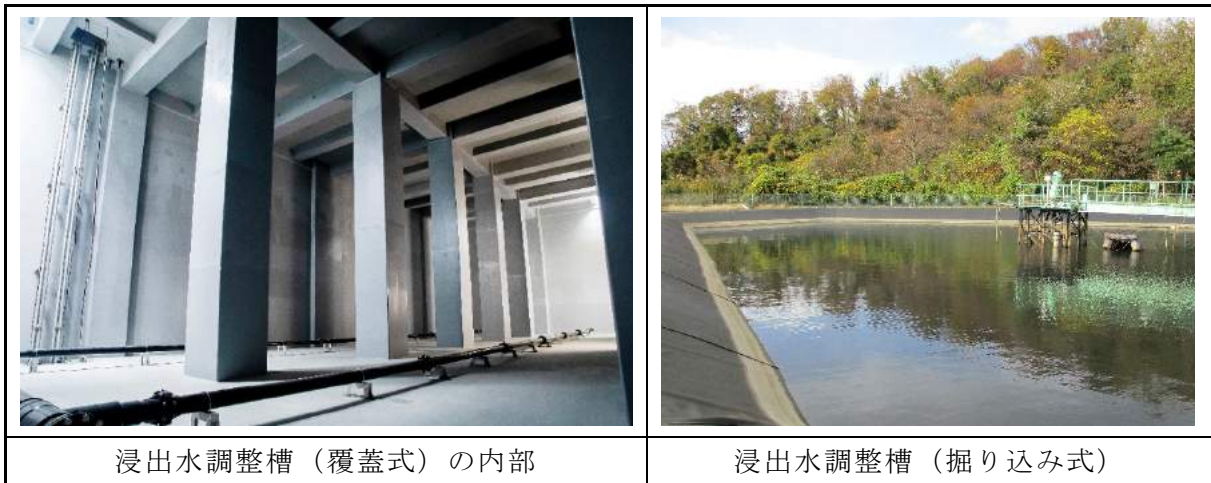
図 2.6.1-5 浸出水処理施設工事イメージ
