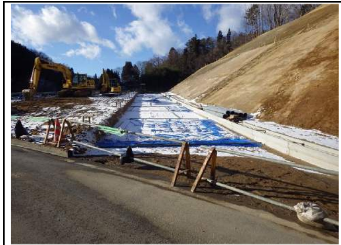
基礎地盤掘削作業の状況
