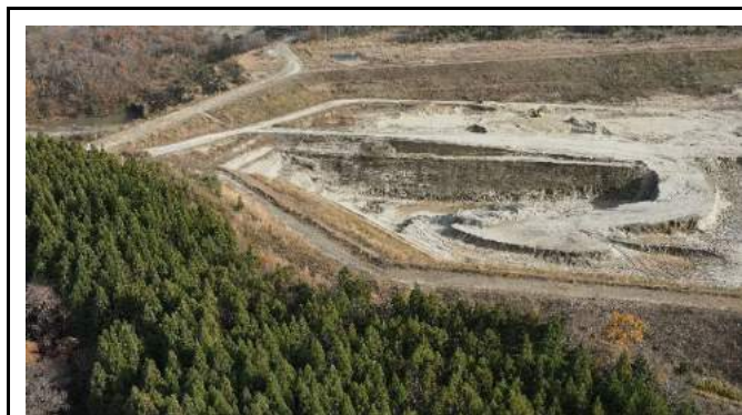
造成工事箇所
