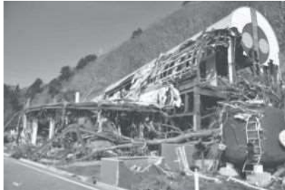
全壊した地下水族科学館もぐらんぴあ
