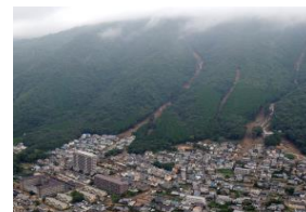
異常な豪雨による激甚な山地災害
