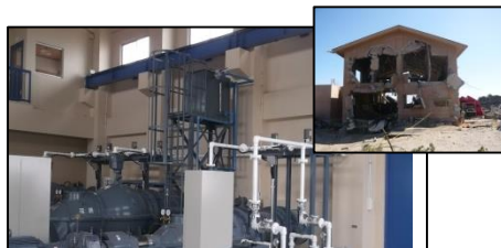
復旧した花笠第2排水機場 (山元町)
