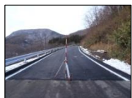
復旧した林道 高倉線(大和町)
