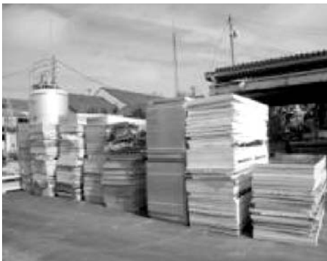
断熱材（ウレタン）置き場
