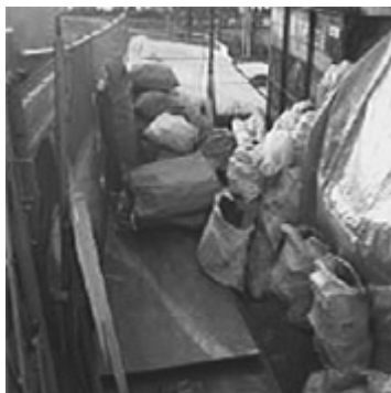
作業前 産廃置き場状況 外壁下地完了 フロア貼り施工中
