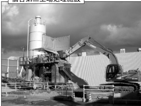
仙台第二工場処理施設
