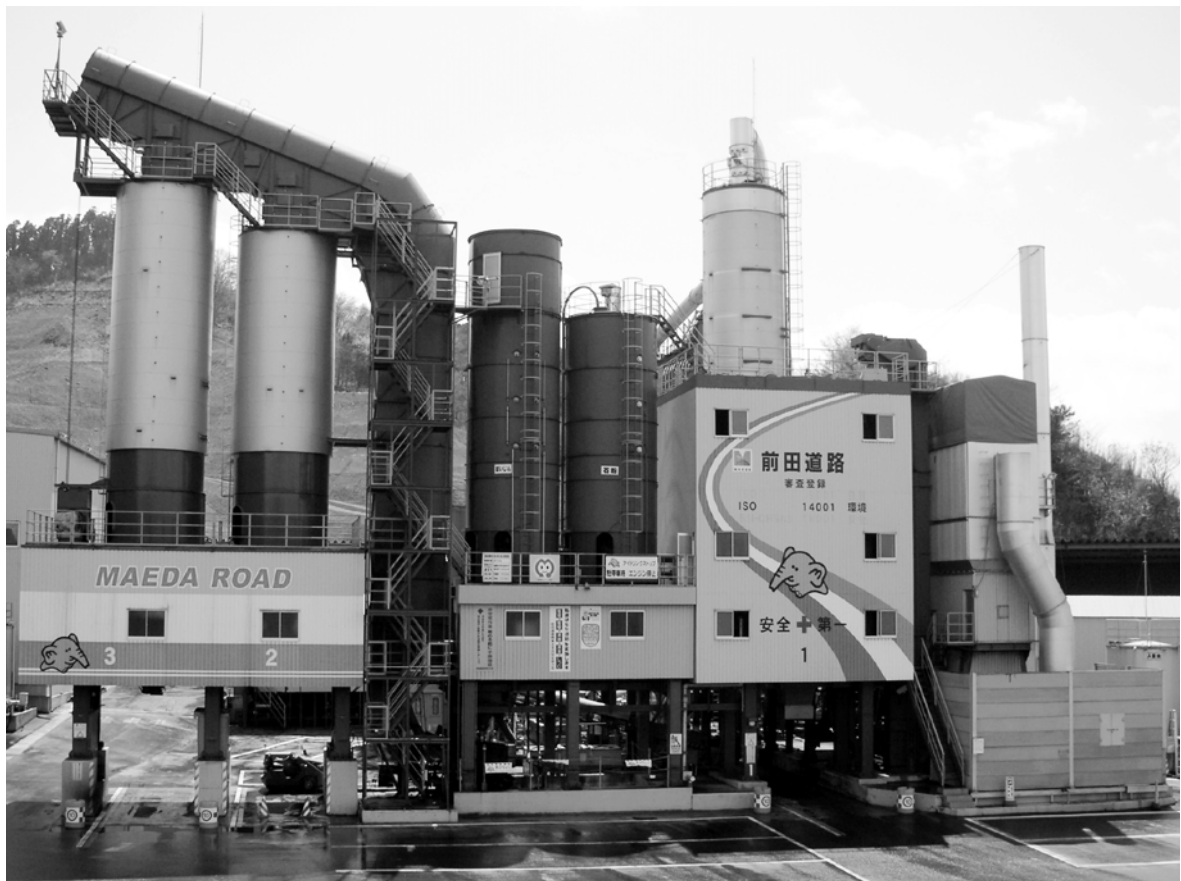
仙台合材工場外観
