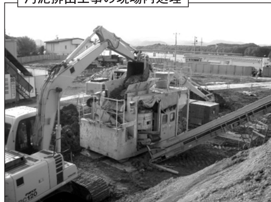
汚泥排出工事の現場内処理
